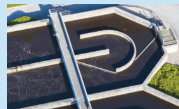
Stație de epurare a apei
