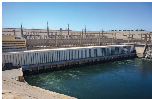
Fig. 2. Barajul de la Aswan (Egipt)
